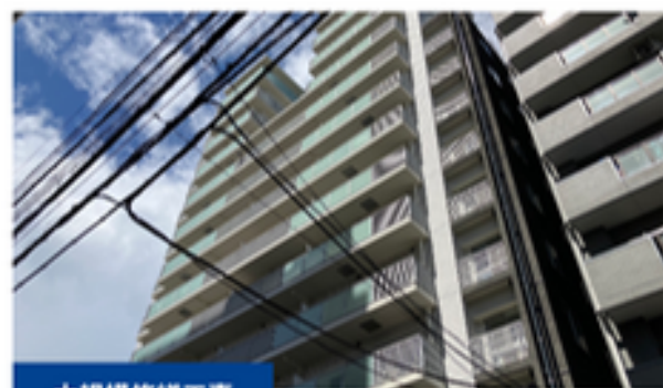
大規模修繕工事
