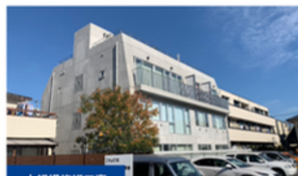
大規模修繕工事
