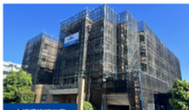
大規模修繕工事
