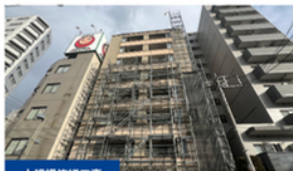
大規模修繕工事
