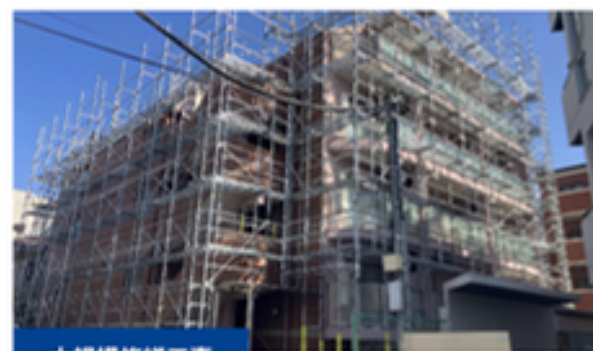
大規模修繕工事
