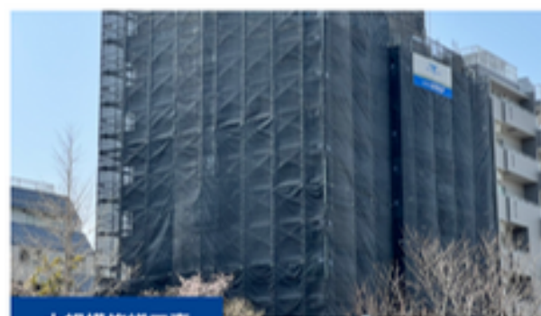
大規模修繕工事
